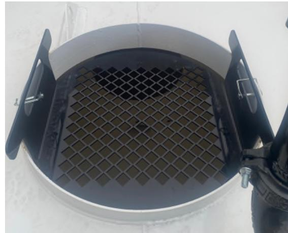
Ubicada en la parte superior del tanque, aquí es donde se llena el tanque con agua, ya sea mediante un tubo de llenado o un tubo de descarga de agua.
